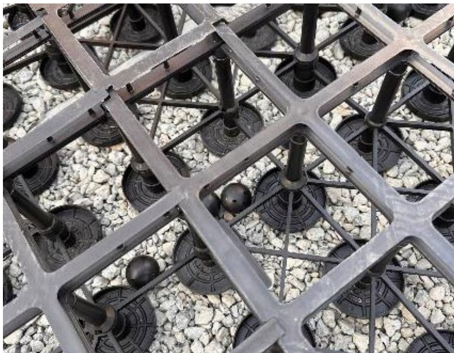
▲ 捷運科技大樓瑞安段南側龍鳳公園鋪面採用 JW 生態工法設計，有效調整水資源循環
