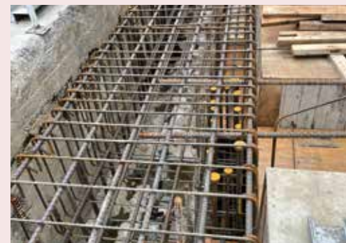
■ 基地周圍安裝灌注式止水條防止連續壁漏水產生
