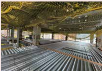
■ 設置樓板防墜網，確保施工安全
