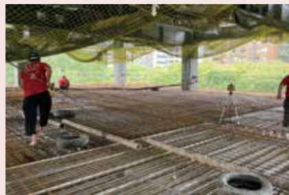
■ 灌漿前安裝表面標高器，避免樓板形成高低差
