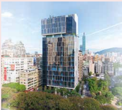
■ 112 年 7 月如期竣工
